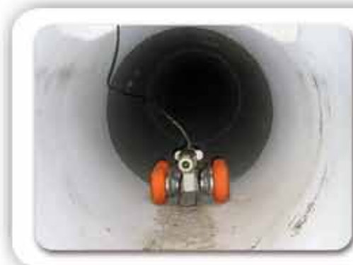
Inspection par caméra
